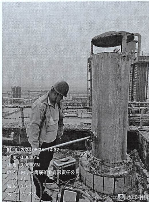
硫铵工段除尘器废气排气筒
